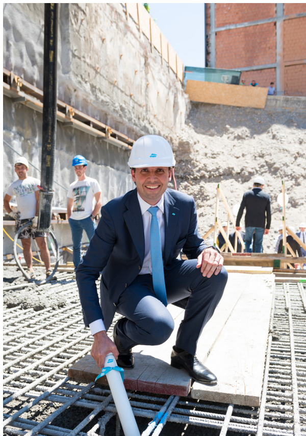
Grundsteinlegung für den Bau des neuen Hauptsitzes im Jahr 2017.
